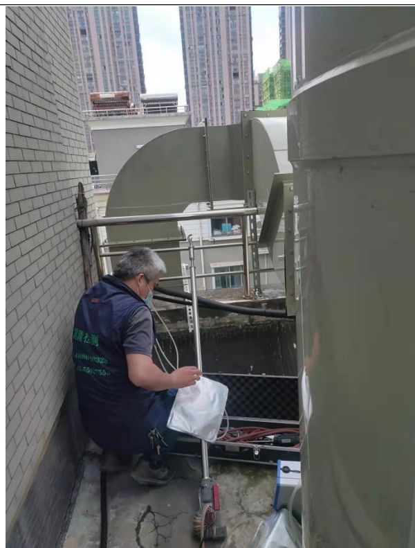
废气处理设施进口取样照片
